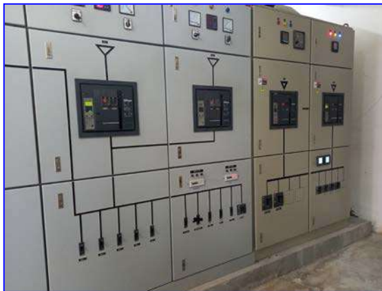
รูปที่ 2.22 ตู้ควบคุมไฟฟ้า (MDB)
